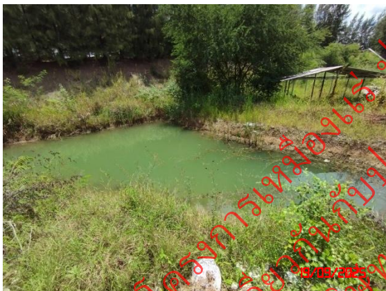
รูปที่ 15 บ่อดักตะกอนของโครงการ
